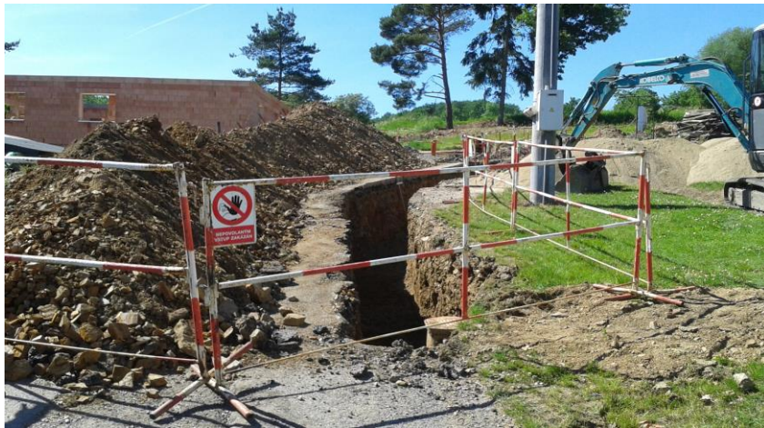
Plynofikace tří stavebních parcel ve Slavoňově, 230.000,- Kč
