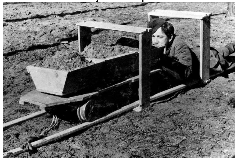
Po válce – ukázka jedné z prací v tunelu Harry
