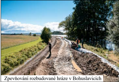
Zpevňování rozbudované hráze v Bohuslavicích
