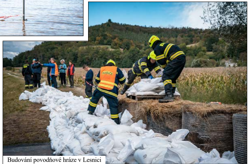
Budování povodňové hráze v Lesnici
